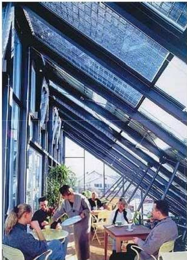
Solar Café a Kirchgarten (D). Particolare della facciata fotovoltaica inclinata. Fonte: catalogo Photowatt
