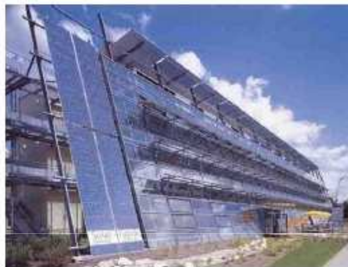
Solar Fabrik, Friburgo. Impianto fotovoltaico: potenza 56 kWp
