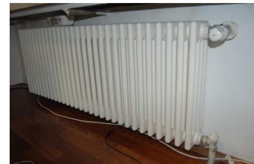
COLLEGAMENTO TRA IL RADIATORE E LE TUBAZIONI DI MANDATA E RITORNO
