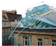
Coop Himmelb(l)au, Roofop Remodelling Falkestrasse , Wien, 1988
