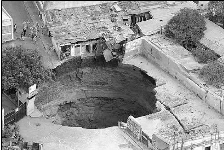
Apertura di una voragine a seguito del crollo della volta di una cavità carsica
