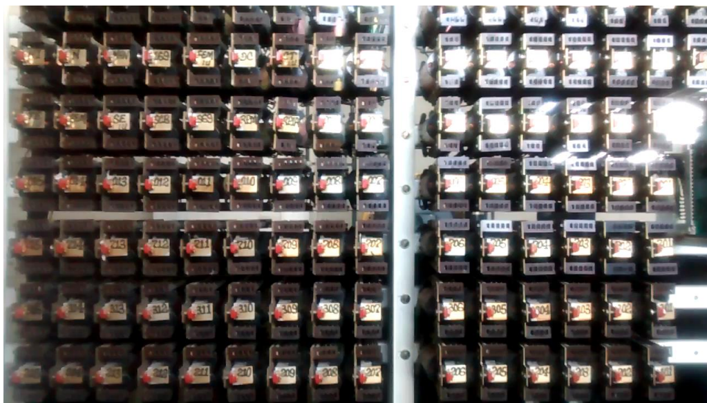
Quadro di comando di un ascensore (Creative Elevadores)
