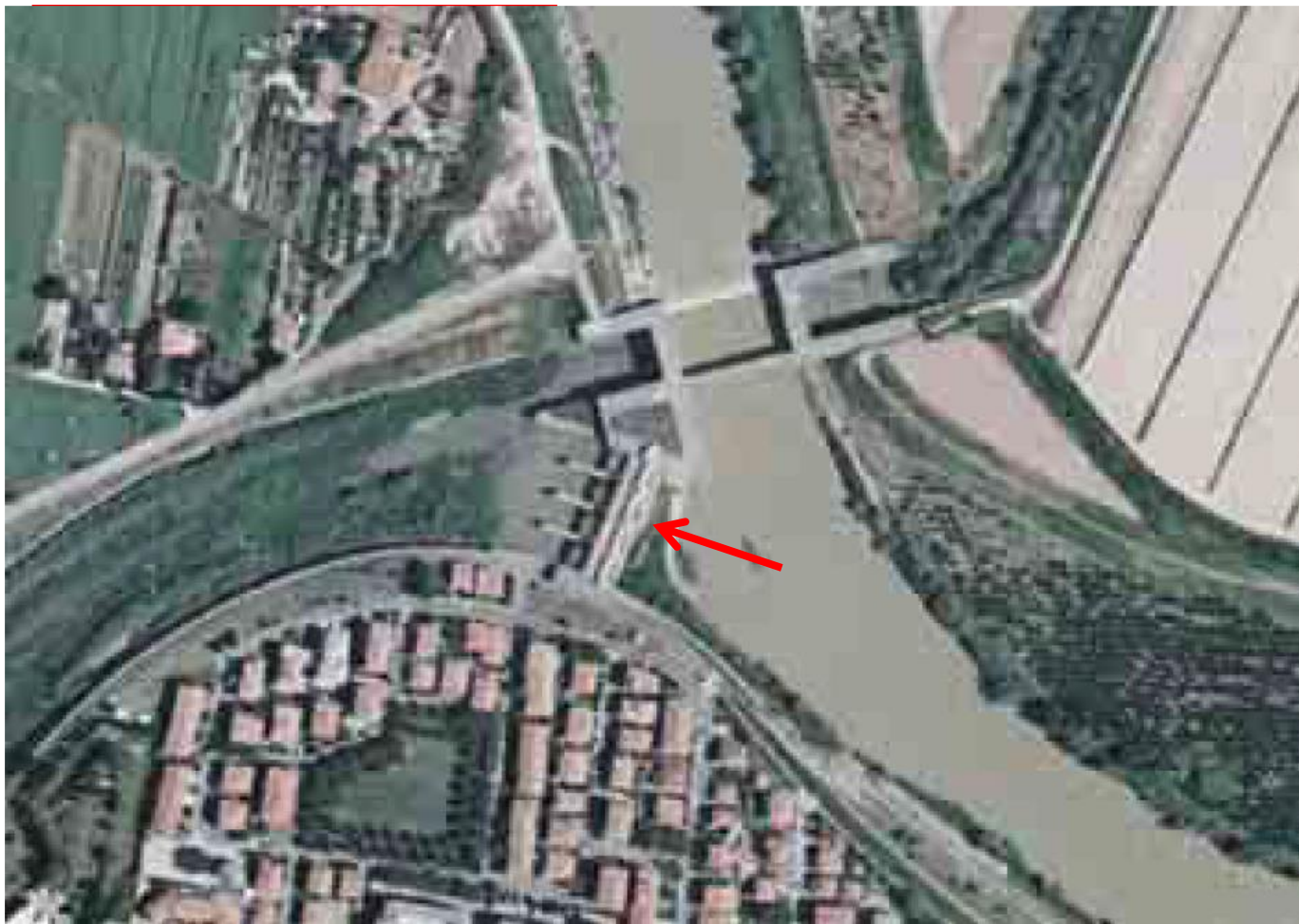
Scolmatore dell'Arno a Pontedera
