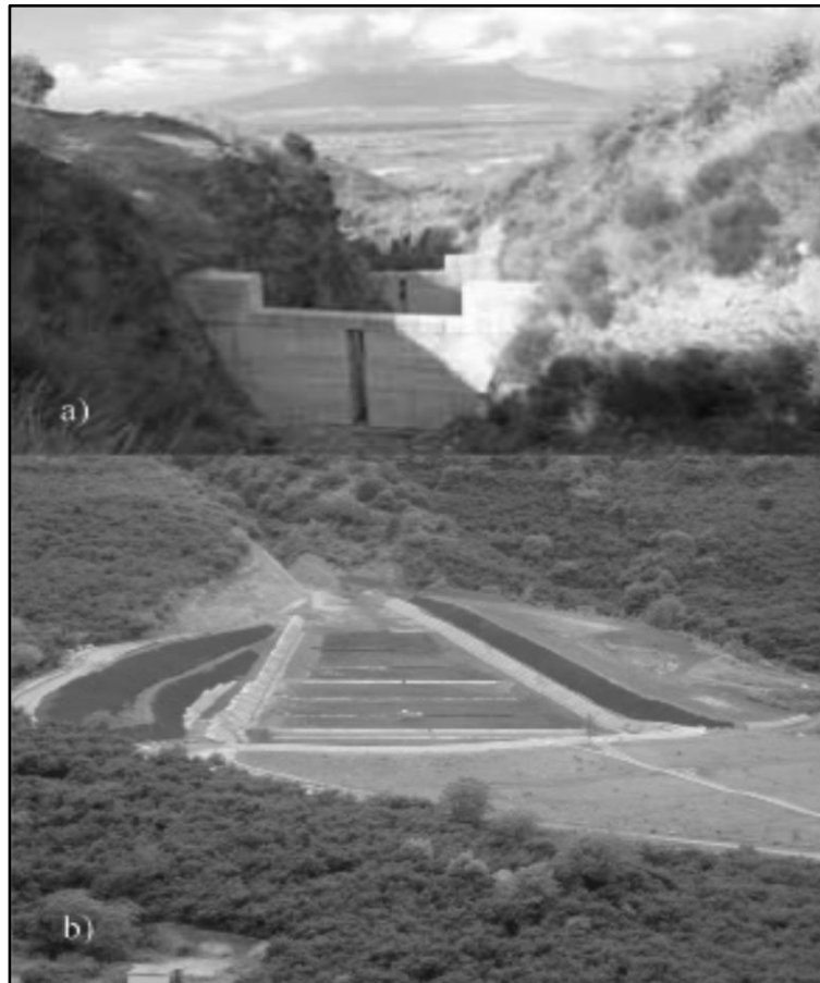
Opere di contrasto e contenimento di colate di fango: a) briglia selettiva; b) vasca di intercettazione del fango allo sbocco del vallone Connola (Quindici).
