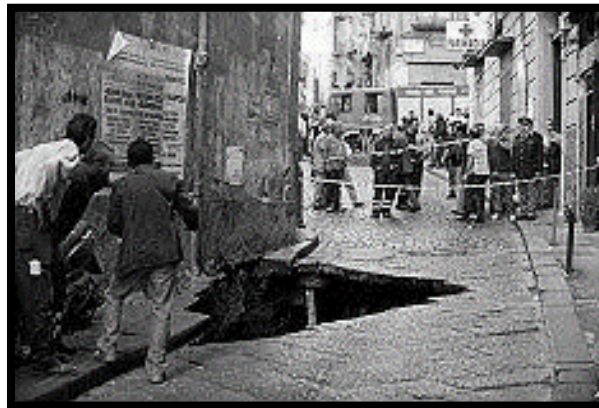
Via S. Carlo alle Mortelle 23/11/2009. Rottura di una grossa condotta fognaria profonda a servizio del quartiere. Apertura di una grossa voragine all'interno della chiesa ed una voragine nella strada limitrofa.
