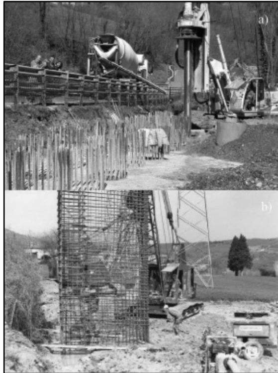
Fasi di realizzazione di paratie di c.c.a. costituite da: a) pali; b) setti.
