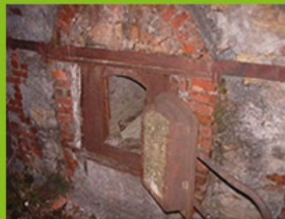
Portale bocche di fuoco
