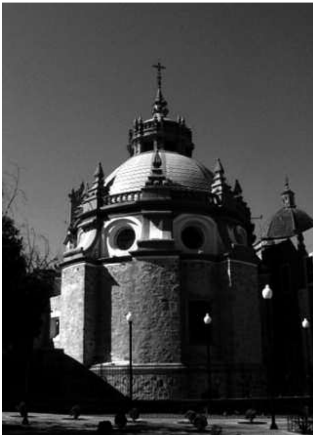
Vista exterior del Camarín, templo de San Diego, Aguascalientes 1792-1797.
