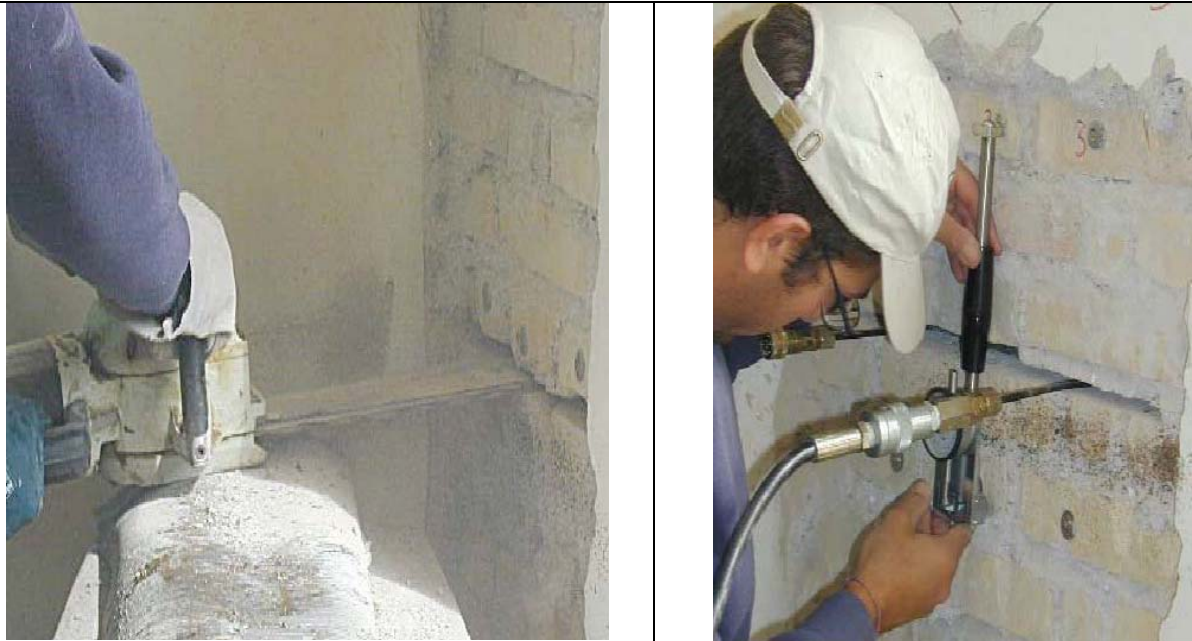
Fig.20 : Messa in opera di un martinetto piatto e misura delle deformazioni a taglio effettuato
