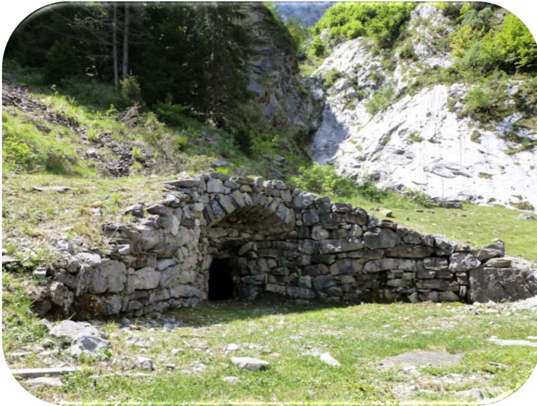
Ingresso della calchera, costruita su un pendio
