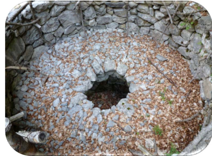
Foro che serve da sfogo, sulla volta della calchera
