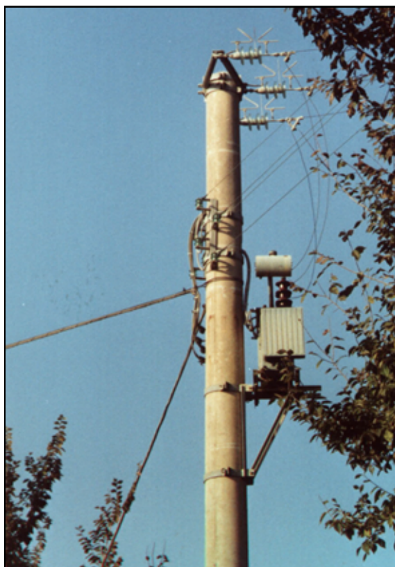
Figura 4.3: esempio di sostegno in cemento armato.
