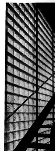
Particolare della scala
