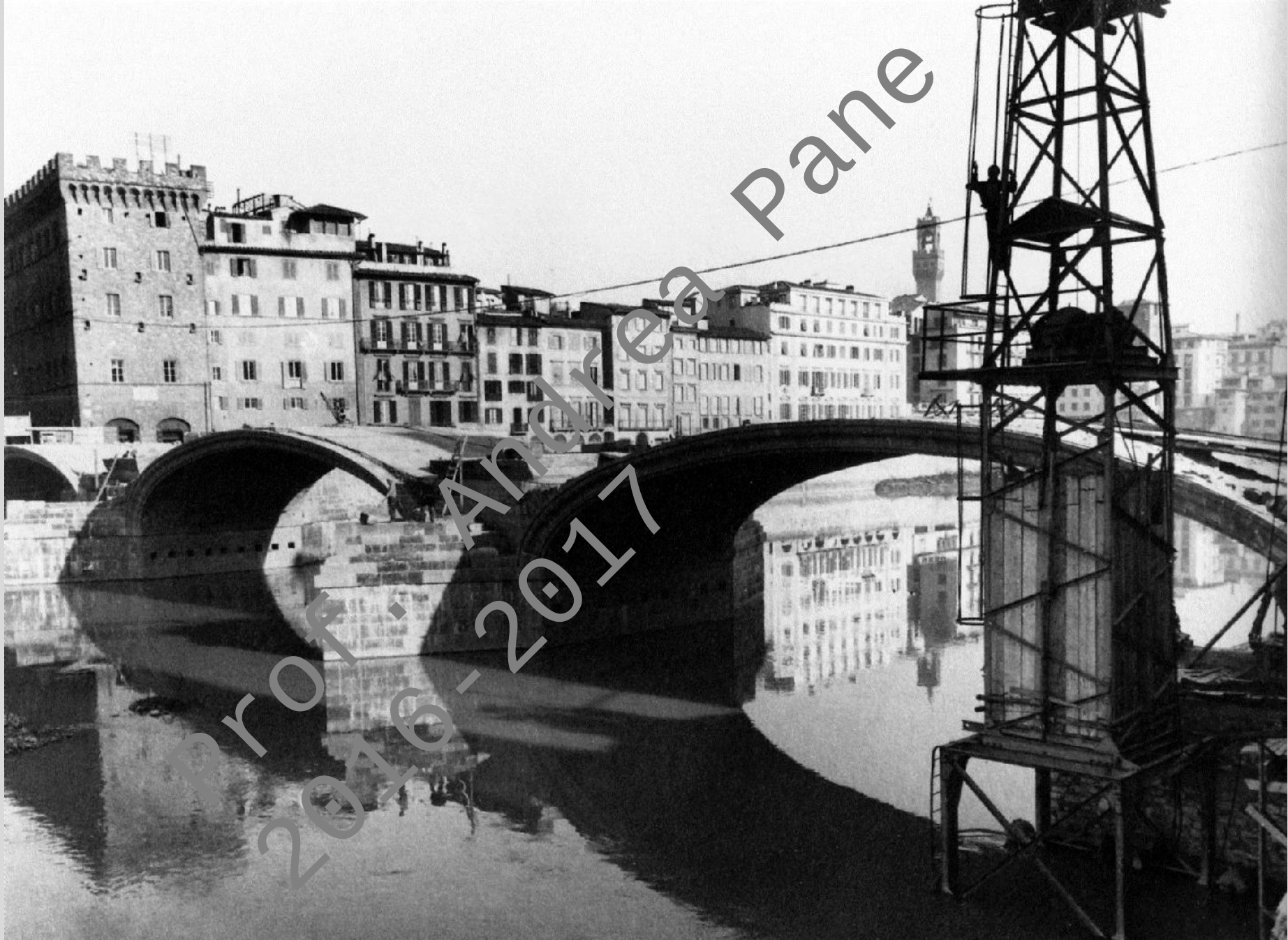
1955-58 Cantiere di ricostruzione del ponte.
