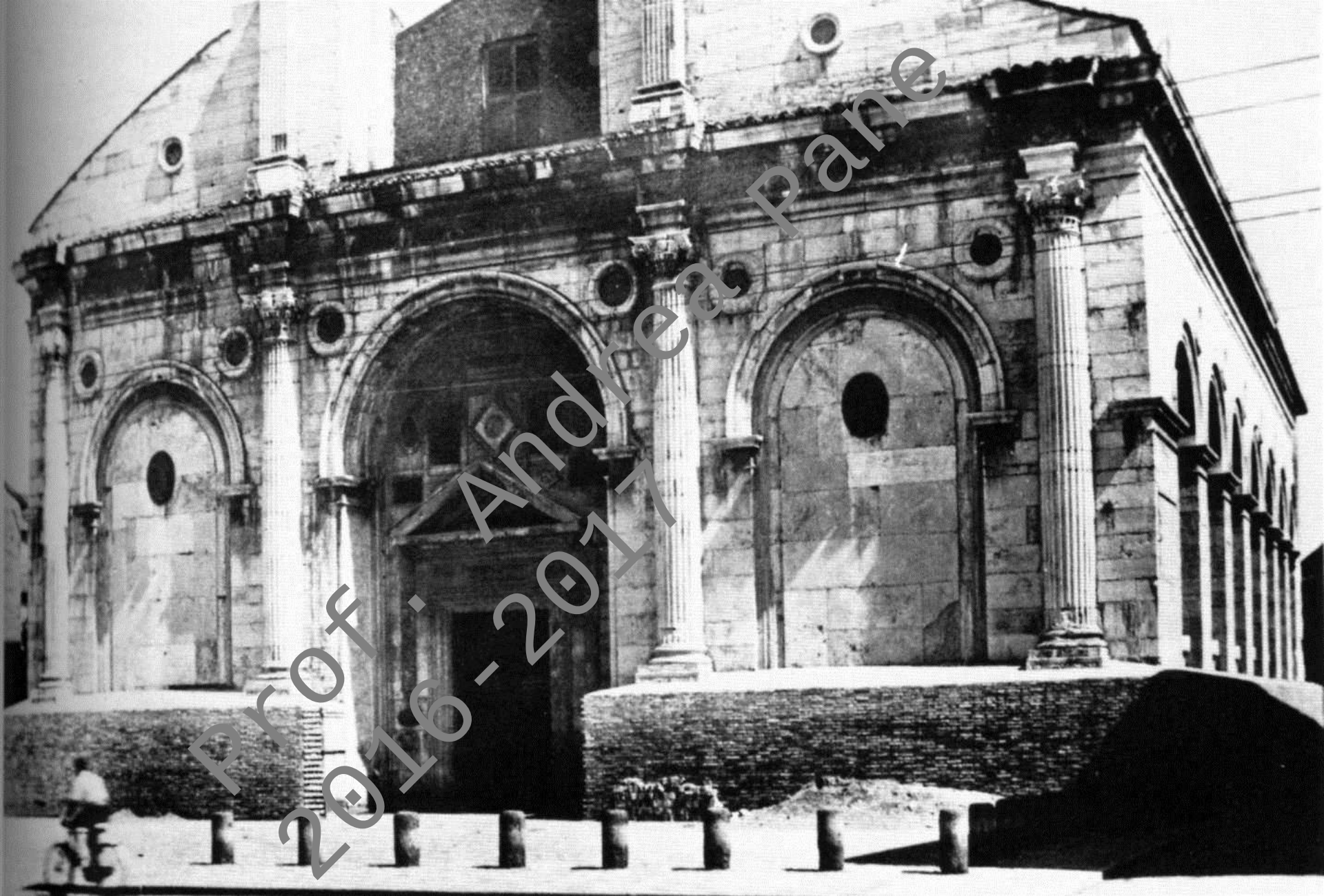
Veduta del Tempio Malatestiano con le opere di protezione delle stilobate, 1941 (SBBAARa).
