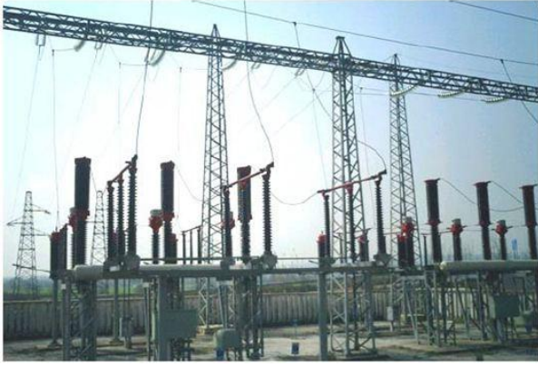
Fig.4.8- Panoramica arrivi linee del reparto AT. Sezionatore AT di arrivo linea.
