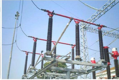
Fig.4.8- Panoramica arrivi linee del reparto AT. Sezionatore AT di arrivo linea.
