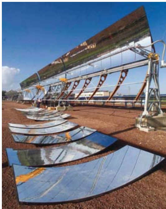
Fig. 14.16 - Particolare degli specchi elementari, a sagoma parabolica, facenti parte del concentratore solare. Prove di montaggio e collaudo presso il campo sperimentale dell'ENEA presso la Casaccia, Roma.
