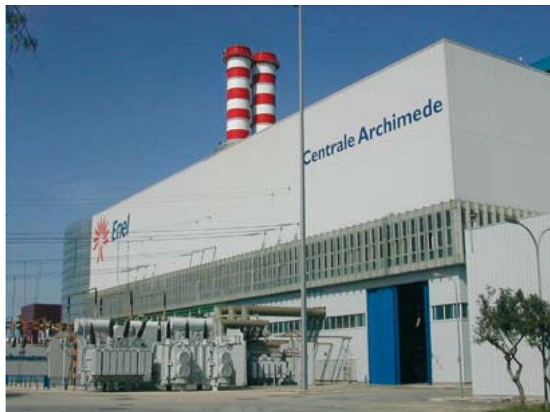
Fig. 14.27 - Centrale termoelettrica ENEL di Priolo Gargallo. Sala macchine della parte a vapore del ciclo combinato.
