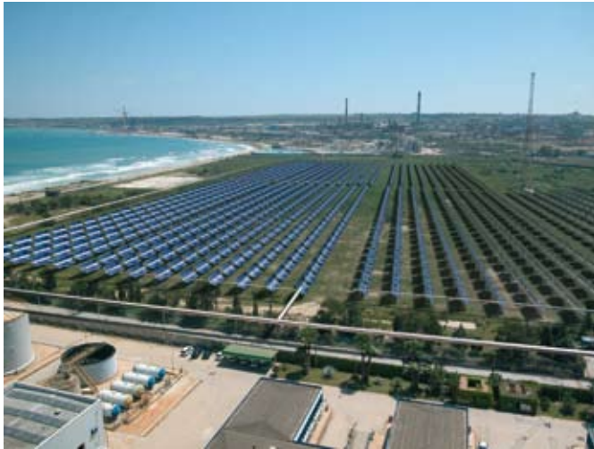
Fig. 14.12 - Elaborazione fotografica del campo solare a specchi parabolici del progetto Archimede nella zona limitrofa a quella dei gruppi termoelettrici a ciclo combinato.
