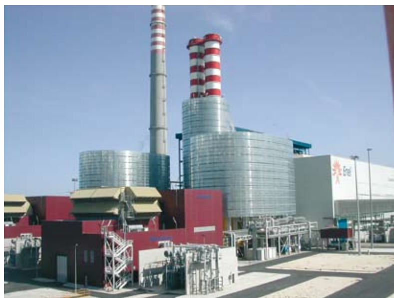
Fig. 14.28 - Centrale termoelettrica ENEL di Priolo Gargallo. Vista dei due gruppi a ciclo combinato con in primo piano gli edifici dei turbogas e, dietro, i due GVR (Generatori di Vapore a Recupero).
