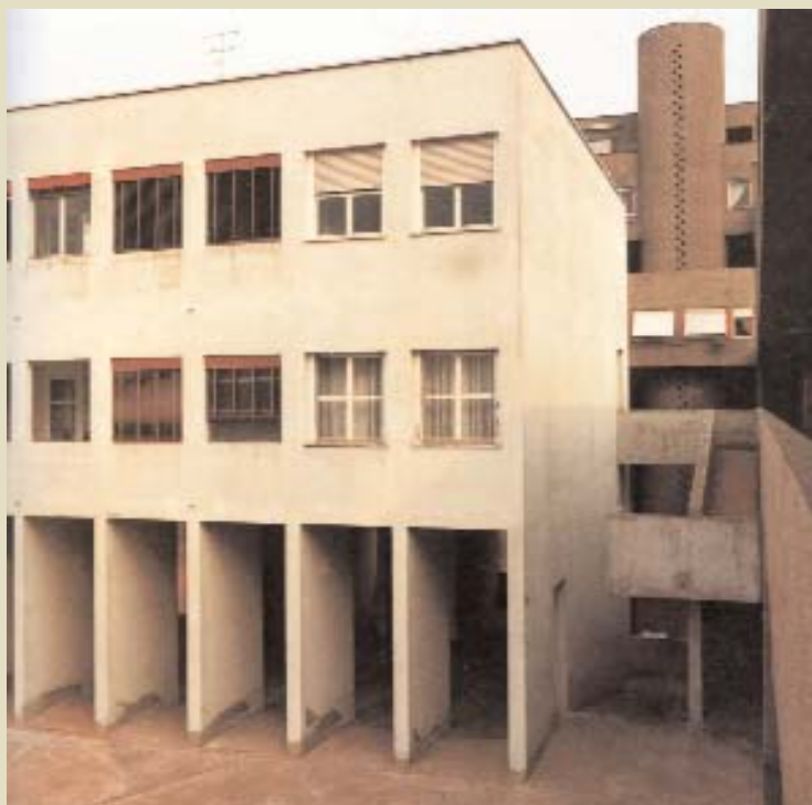
A lato, un'immagine degli anni Ottanta dell'Unità d'abitazione al quartiere Gallaratese di Milano (1969-1970), opera di Aldo Rossi: in evidenza i fenomeni di degrado sulla facciata. Nelle altre immagini, gli esiti del recente intervento di manutenzione della facciata (foto Luca Maria Francesco Fabris).
