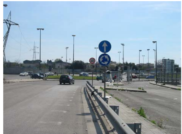
Figura 13 Segnale rotatoria in posizione inadeguata accoppiato con segnale di obbligo incongruente (rotatoria 8, Via Pacioli).
