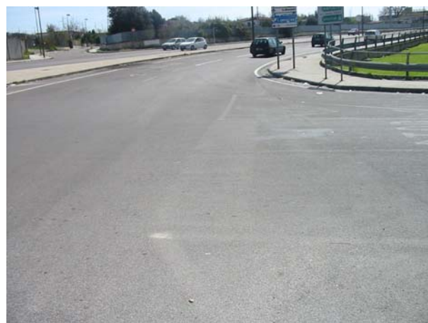
Figura 6 Segnaletica orizzontale di precedenza inefficace (V.le delle Metamorfosi) della rotatoria 8 (5 incidenti per scontro fronto-laterale in ingresso).
