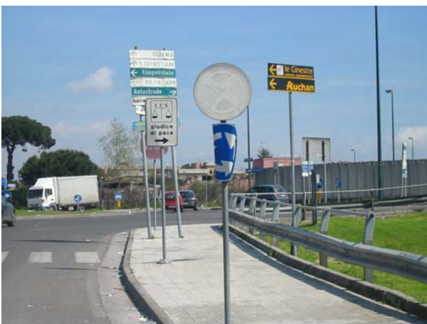
Figura 12 Segnale rotatoria “inefficace” (rotatoria 8, V.le Metamorfosi).
