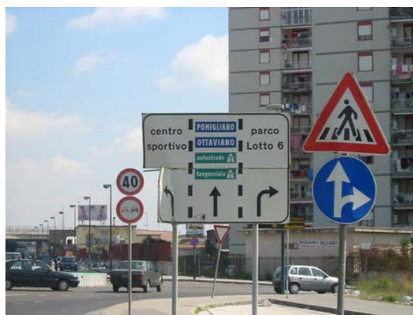
Figura 8 Segnaletica di preselezione installato in luogo del segnale preavviso rotatoria (rotatoria 1, Via Argine).
