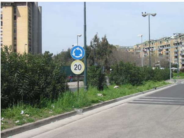
Figura 11 Segnale rotatoria installato in posizione inadeguata (rotatoria 3, via Ghisleri).
