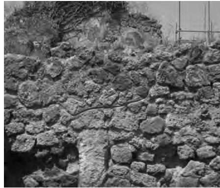
Fig. 11 – Pompei, via Marina, la «linea riflessata» voluta da Maiuri per delimitare la parte di muro antico rispetto a quella ricostruita nei restauri post-bellici. Foto R. Picone 2008.
