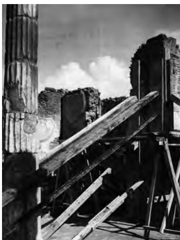
Fig. 7 – Pompei, la Casa del Fauno durante i lavori post-bellici, 1947. Archivio fotografico ASANP, neg. A368.
