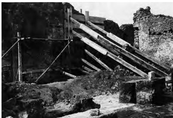
Fig. 8 – Pompei, la Casa del Fauno durante i lavori post-bellici, 1947. Archivio fotografico ASANP, neg. A367.
