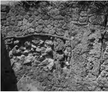
Fig. 10 – Pompei, via Marina, la «linea di sutura» in laterizio voluta da Maiuri per delimitare la parte di muro antico rispetto a quella ricostruita nei restauri post-bellici. Foto R. Picone 2008.
